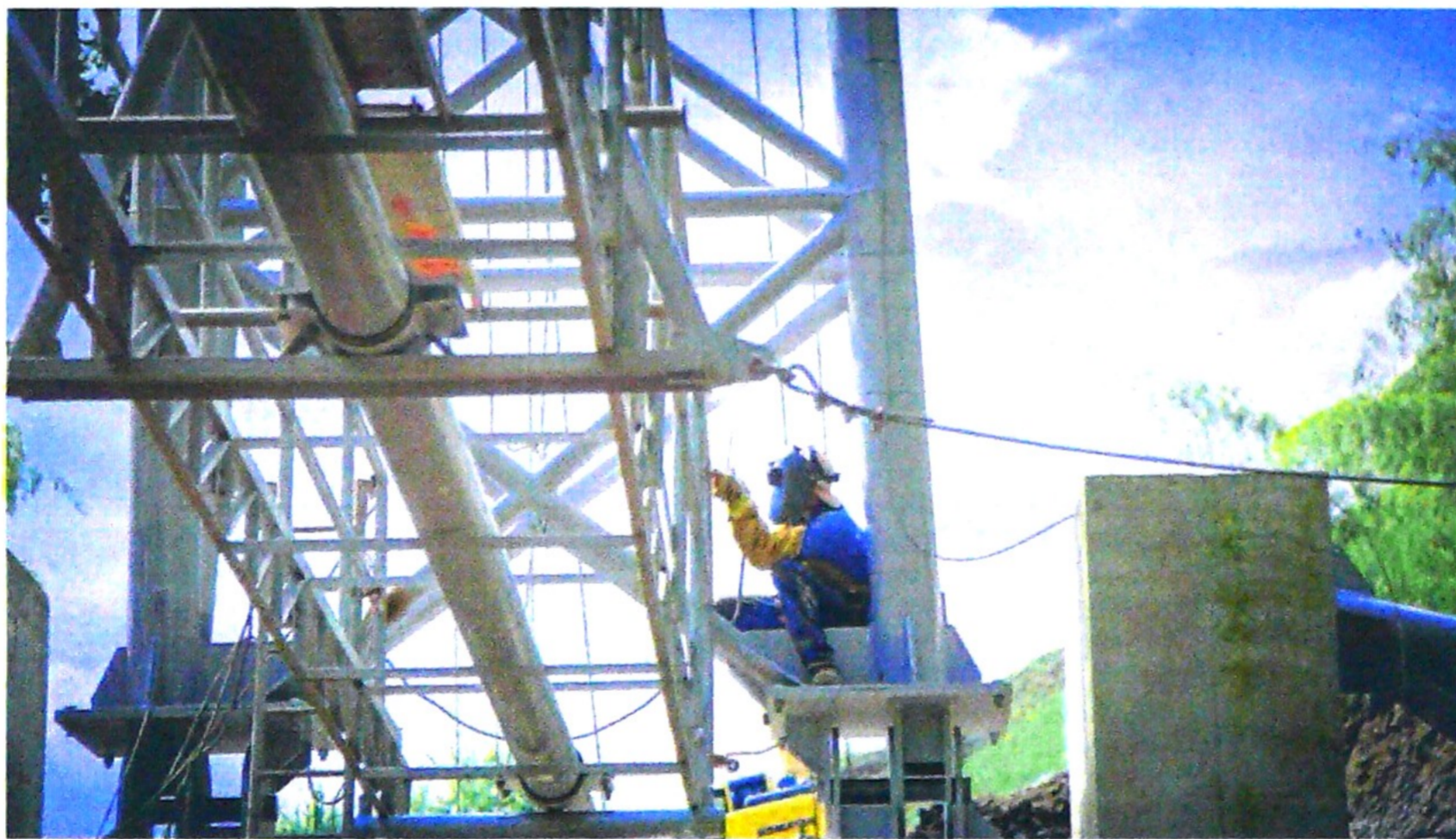
Montaje poliducto Salgar-Cartago-Yumbo, tiene una extensión de 55,2 kilómetros, se invirtieron US$81 millones. Ecopetrol
