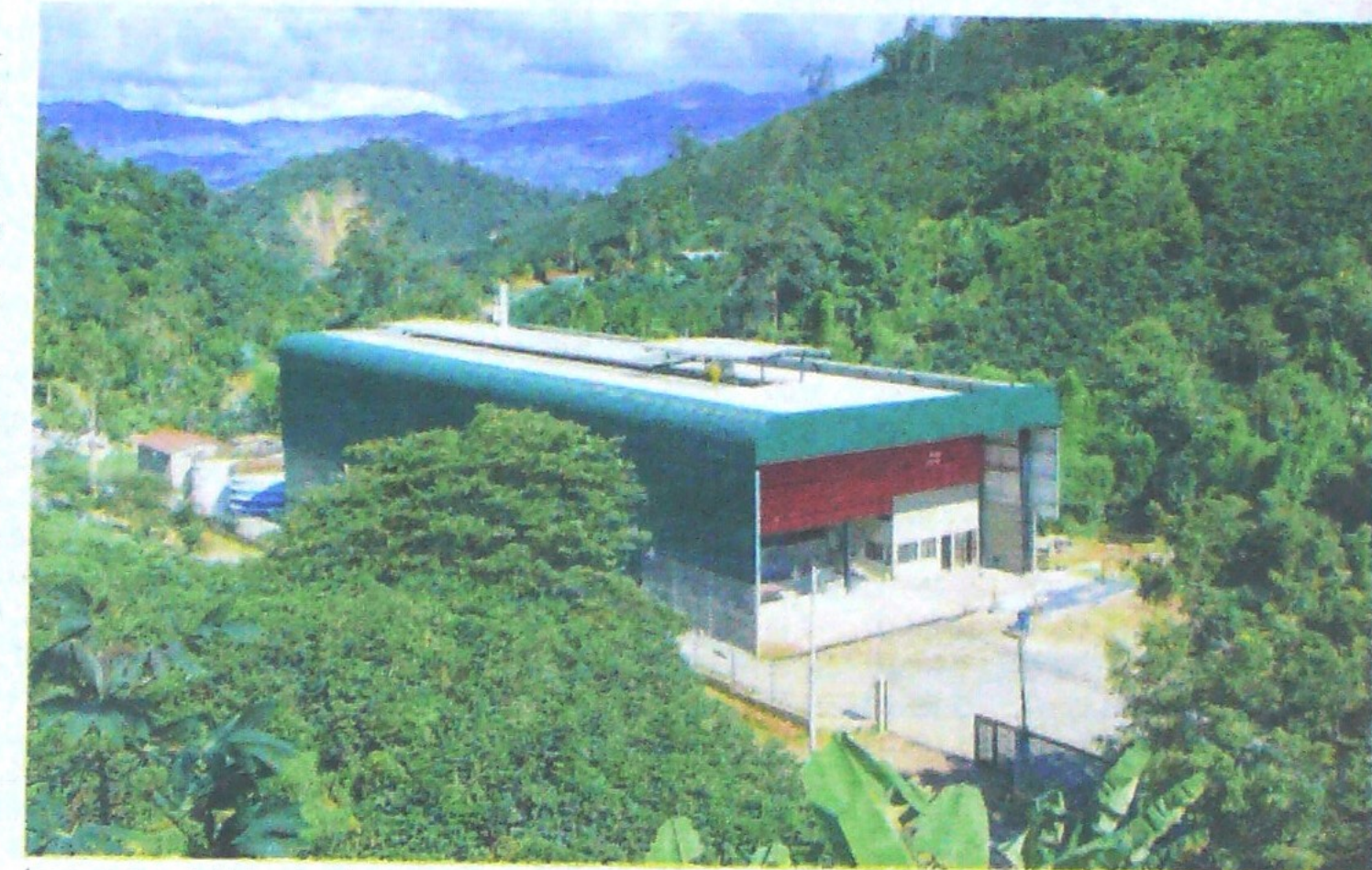
La compra del lote donde se construyó la planta de beneficio de La Chaparrala se señala como una de las malas decisiones tomadas por la administración de la cooperativa. FOTO CORTESÍA DELOSANDES
