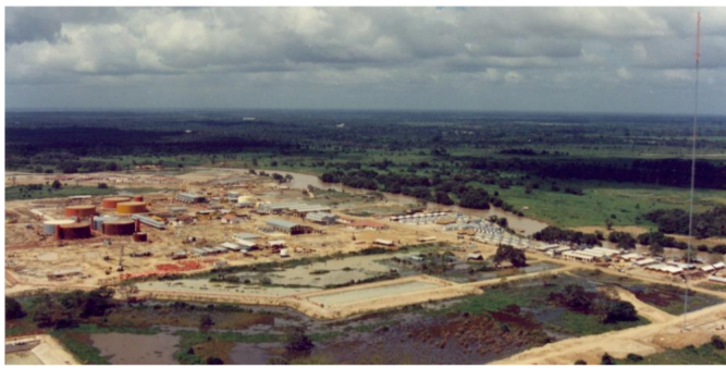
Panorámica del campo petrolero Caño Limón, que opera Occidental de Colombia, en Arauca. Foto: Archivo / EL TIEMPO
