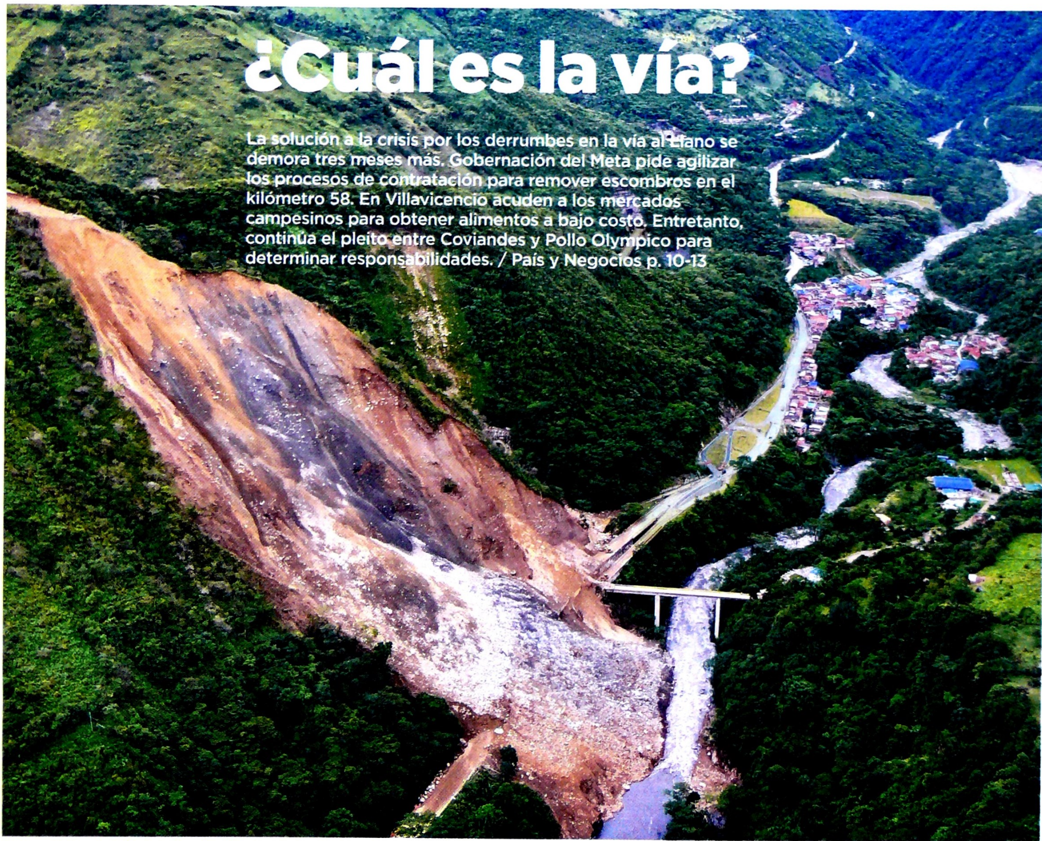
Así luce el kilómetro 58 de la vía Bogotá - Villavicencio tras del derrumbe que obligó a cerrar el paso desde el 9 de junio. / Hibert Ricardo Rubiano
