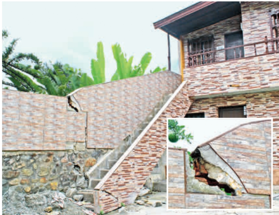
En estas condiciones está una de las primeras casas que tuvieron que ser evacuadas por el movimiento de masas y la aparición de las grietas. La construcción se está inclinando hacia el oriente.
