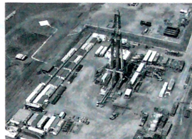
La plataforma luego se trasladará al pozo Andina-3. Ecopetrol
