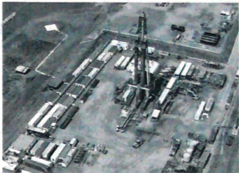
La plataforma luego se trasladará al pozo Andina-3. Ecopetrol
