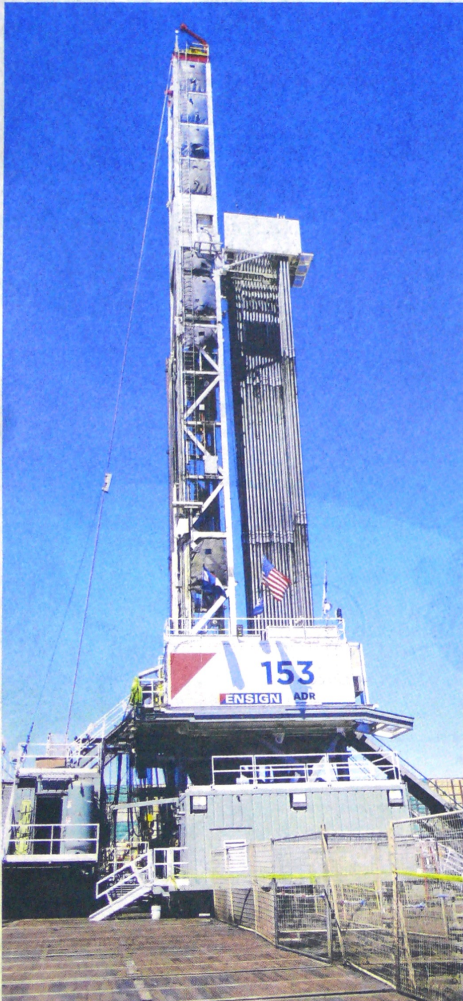
La instalación de Creston Peak, en Colorado, es una de las más avanzadas de toda la industria.
