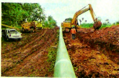
Tramo Jobo-Majaguas, del gasoducto que amplió Promigás entre el campo Jobo y Cartagena. FOTO: CORTESÍA PROMIGÁS
