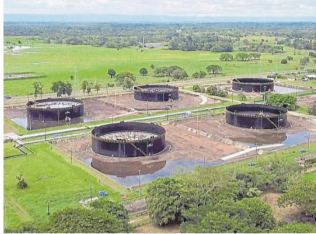
Así es el aspecto que tiene en estos momentos la terminal de Vasconia del Oleoducto de Colombia. CORTESÍA OLEODUCTO DE COLOMBIA
