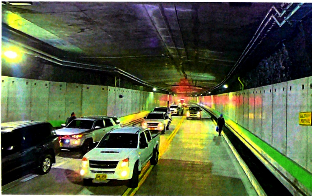
El túnel tiene 109 cámaras de seguridad y un centro de control que opera las 24 horas. FOTO: JÁVER NIETO. EL TIEMPO
