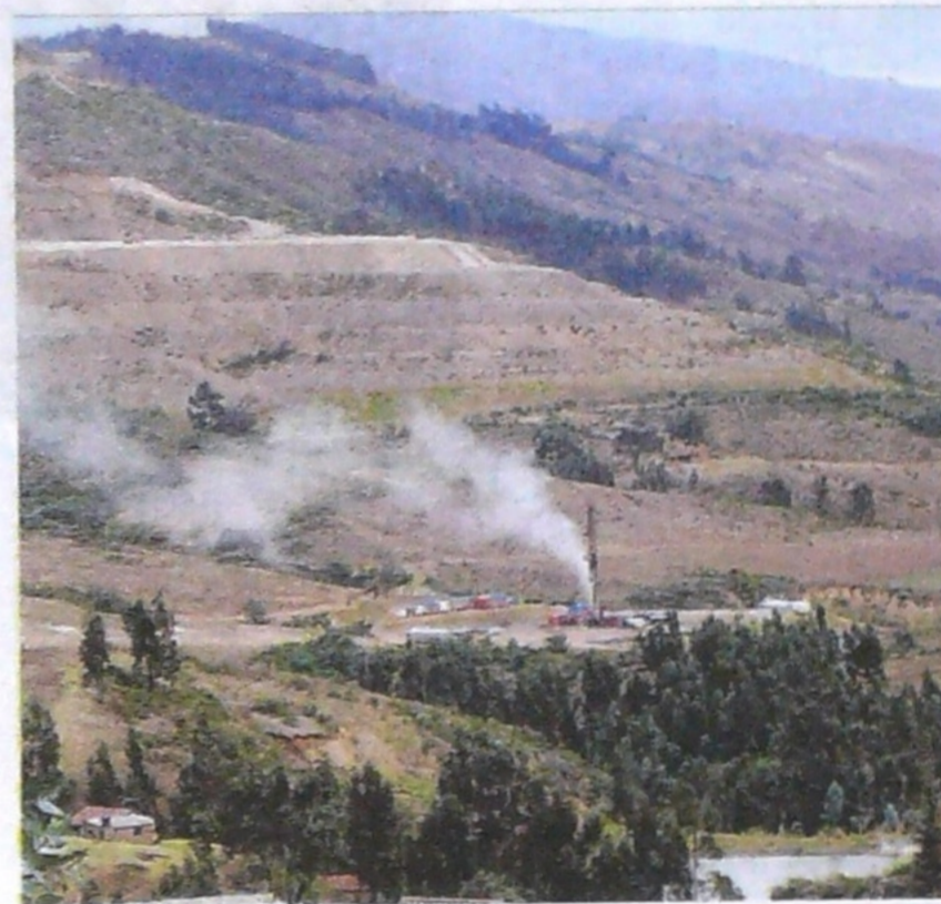
Pozo de hidrocarburos de la empresa Omega Energy en la jurisdicción del municipio de Corrales, Campo Corrales, Bloque Buenavista.
