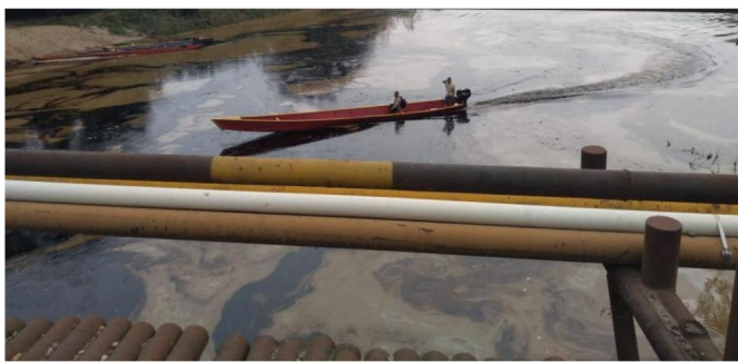
La caída de crudo en tres cuerpos de agua del municipio de Tibú desató una emergencia ambiental que suspendió el suministro de agua a la población. Foto: Cortesía del Consejo Departamental de Gestión del Riesgo de N. de Santander
