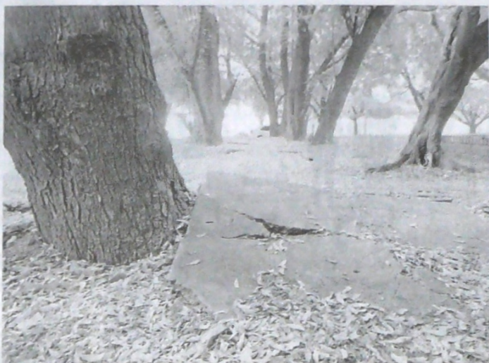
EN SU TOTALIDAD, EL PISO DEL PARQUE DE CEIBA ESTÁ QUEBRADO y en algunos lugares hundido, debido al abandono en que se encuentra el escenario desde hace 25 años.
