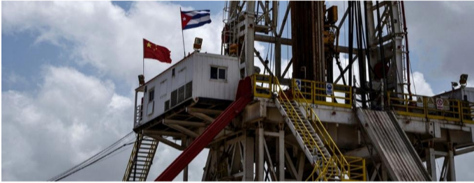
En el sitio se utiliza a instancias de los expertos chinos, la técnica del lodo base de aceite, una mezcla de productos químicos que permite avanzar de manera más rápida y segura en la perforación, pues enfría y lubrica las barrenas.
