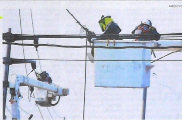
Contratistas de Electricaribe realizan labores de mantenimiento de redes.
