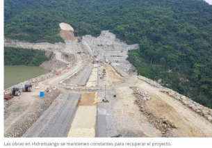
Las obras en Hidroituango se mantienen constantes para recuperar el proyecto. Foto: Guillermo Ossa / EL TIEMPO
